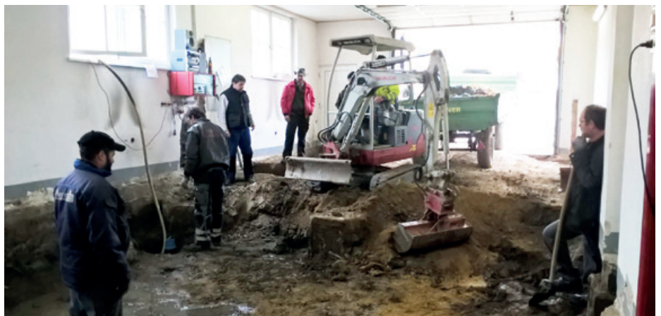
Der Hallenfußboden im FF-Haus in Gösing wird derzeit von der Freiwilligen Feuerwehr Gösing in Zusammenarbeit mit der Firma Baumanagement Maier saniert. Die Marktgemeinde Fels unterstützt dieses Projekt finanziell.
