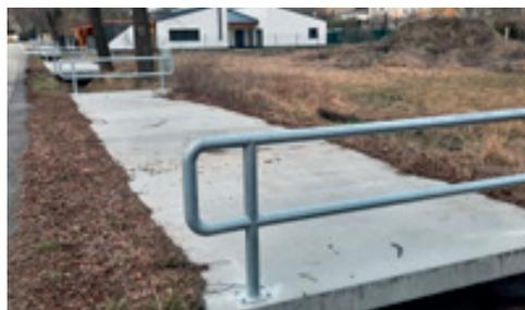
**Neue Geländer in Thurnthal:** Auf den Betonplatten, die über den Ortsgraben führen, hat die Firma Pferschinger aus Fels Absturzsicherungen montiert.
