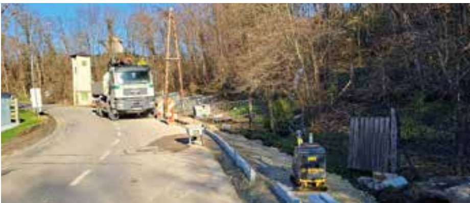
Der Geh- und Radweg wird die Verkehrssicherheit für Fußgänger und Radfahrer massiv erhöhen.
