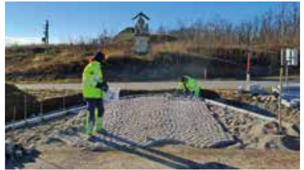
Pflasterarbeiten entlang des neuen Geh- und Radweges.
