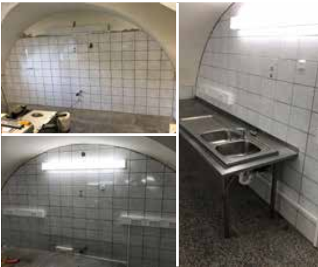
Die Küche hat neue Fliesen bekommen.
