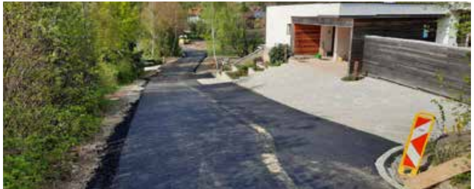
Asphaltierungen „Am Berg“ und „Birkenweg“.
