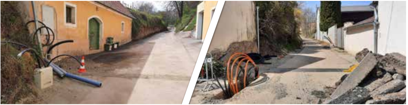
Infrastrukturarbeiten in der Kellergasse Bruckergraben.
