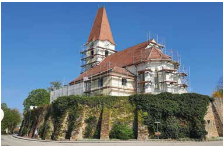
Die Außenanierungen der Felser Pfarrkirche sind in vollem Gange.
