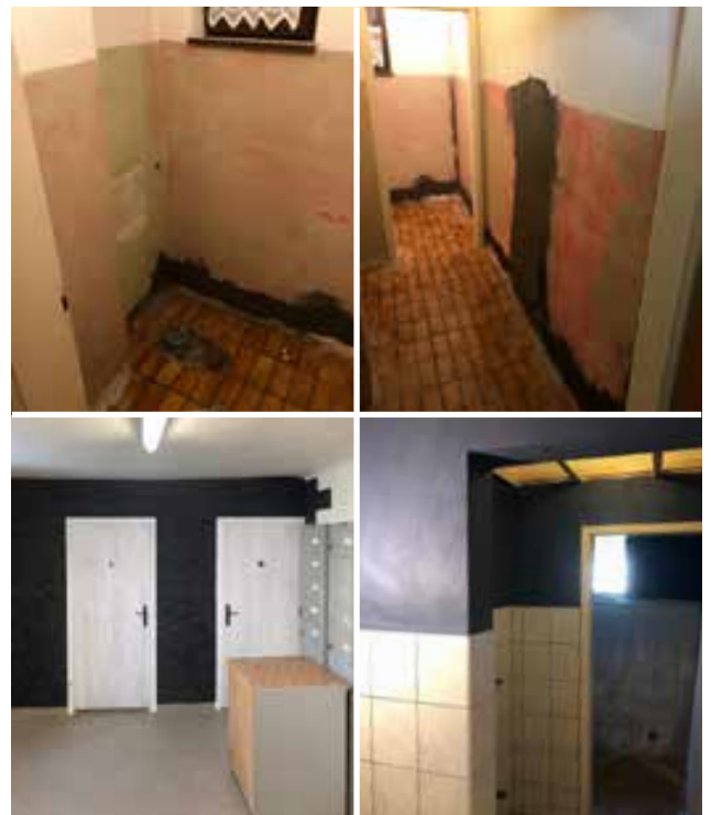
Die Sanitäreinrichtungen wurden erneuert.
