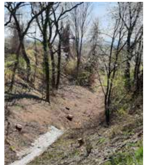
Sanierung der Ortsgräben und Wassersickerungsbecken.
