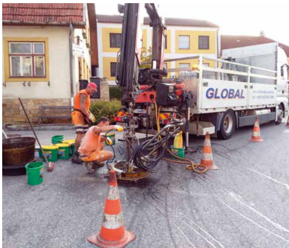
Rund 25 Schachtdeckel im Gemeindegebiet wurden von der Firma Global in den vergangenen Wochen saniert.
