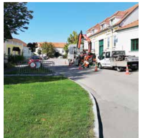
Austausch Schachtdeckeln: Die Firma Global erneuerte einige kaputte Schachtdeckeln in unserem Gemeindegebiet.
