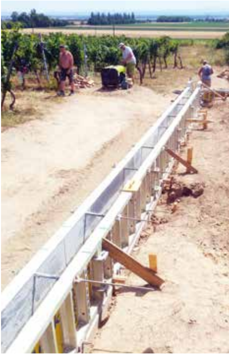
Arbeiten der Wildbachverbauung: Die Wildbachverbauung hat Böschungssicherungsarbeiten in der Kellergasse Mitterweg durchgeführt. Hierdurch wird ein weiteres Abrutschen der Böschung bei Starkregenereignissen verhindert.
