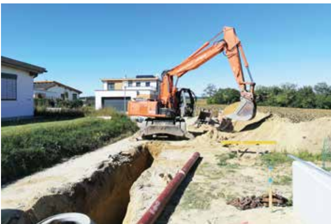
Straßenbau in Stettenhof: Die Firma Leithäusl hat bereits mit den Straßenbauarbeiten am Sonnenweg in Stettenhof begonnen. Derzeit werden für drei neue Baulandgrundstücke die Kanal- und Wasserinfrastruktur hergestellt. Im Anschluss beginnen die Oberflächengestaltungsarbeiten für den Sonnenweg.
