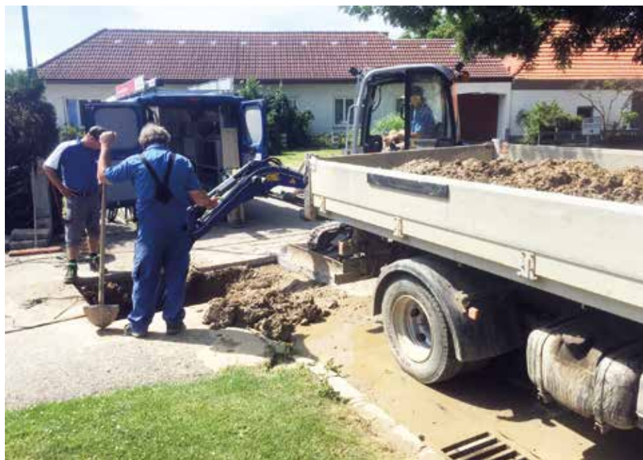
Rohrbruch in Thürnthal: Die Firma Gartner aus Sittendorf hat gemeinsam mit unseren Bauhofmitarbeitern einen Wasserleitungsrohrbruch in der Schlossstraße in Thürnthal behoben.
