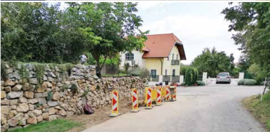
Straßenbaukleinsanierungen: Die Firma Porr führt derzeit diverse Straßenbaukleinsanierungen im Gemeindegebiet durch. Unter anderem werden neue Regenwassereinflaufschächte gesetzt und Künetten asphaltiert.
