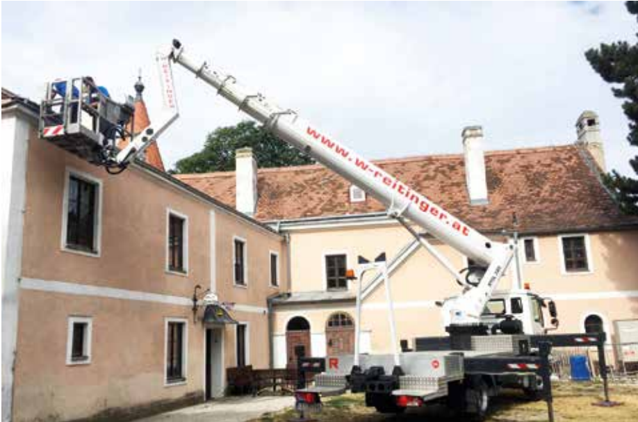
Schloss Fels: Unsere Bauhofmitarbeiter reinigten die Dachrinnen des Schlosses Fels. Im gleichen Zuge wurde auch die Blitzschutzanlage saniert.
