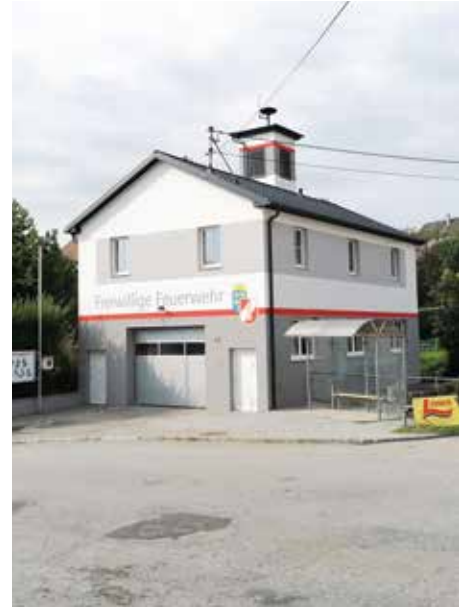
Außensanierung FF-Haus Gösing: Die Außensanierung des FF-Hauses in Gösing ist vor kurzem abgeschlossen worden. Vielen Dank bei den vielen freiwilligen Mitgliedern der FF-Gösing für ihre Unterstützung. Die Kosten der externen Firmen wurden zur Gänze von der Gemeinde getragen.
