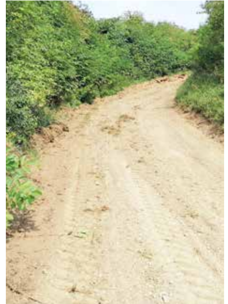
Sanierung von Güterwegen: Die Firma Hengl saniert derzeit Güterwege zwischen Stettenhof und Hohenwarth. Diese Arbeiten werden mit einem Grader und einer Walze durchgeführt.
