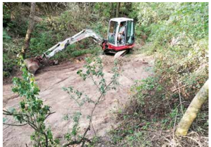
Herstellung von Versickerungsbecken: Die Firma Erdbau Schopf stellt derzeit Regenwasserversickerungsbecken nördlich angrenzend an die Ortschaft Thürnthal her um bei Starkregen eine gefahrlose Regenwasserableitung gewährleisten zu können.
