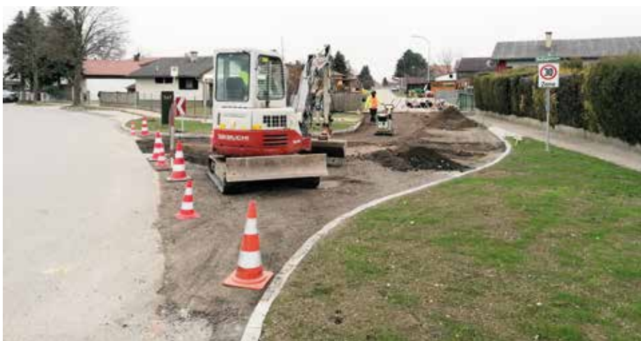
Siedlungsstraße in Fels: Die Firma Leithäusl hat heuer die Asphaltierungsarbeiten bei der Kreuzung Siedlungsstraße/Weinbergstraße in Fels abgeschlossen.
