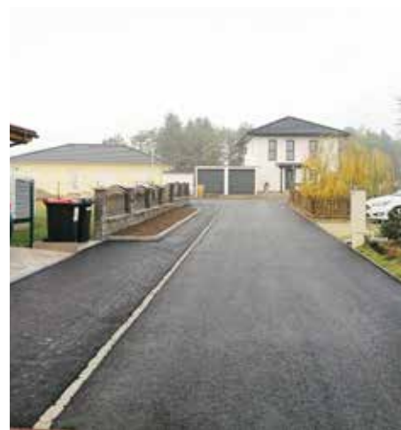
Asphaltierung Sonnenweg: Die Firma Leithäusl hat vor kurzem die Asphaltierung der Straße am Sonnenweg fertiggestellt.
