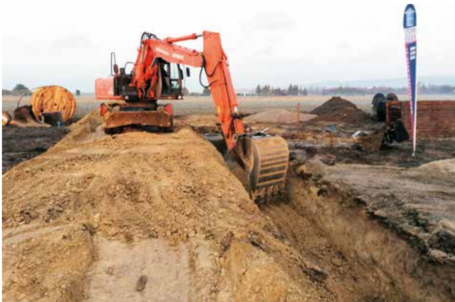
Am Kogel in Fels: Die Firma Leithäusl hat heuer die Erschließung von fünf neuen Baugrundstücken Am Kogel in Fels durchgeführt.
