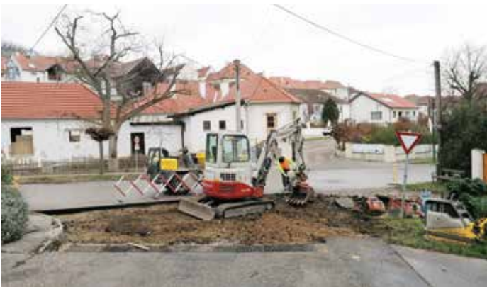
Im Dezember führt die Firma Leithäusl noch die letzten Kleinsanierungen im Gemeindegebiet durch.
