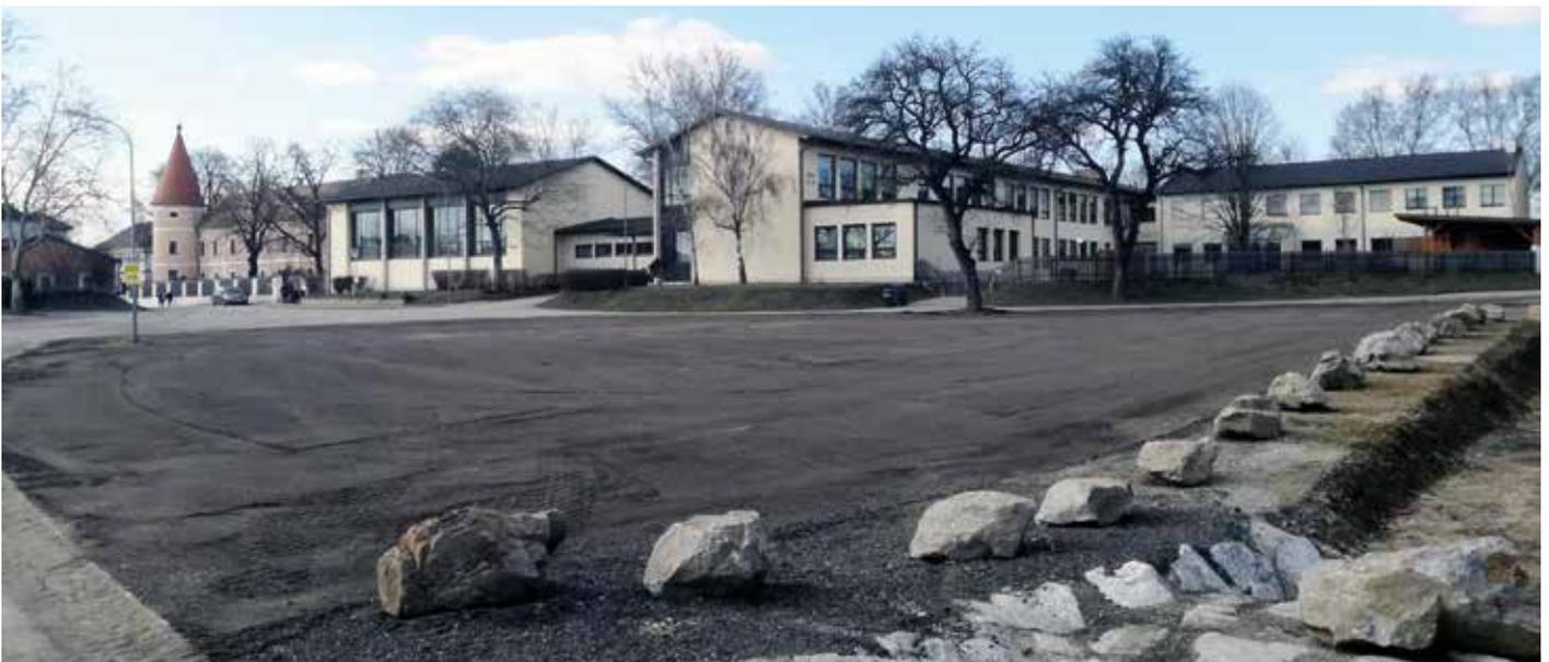
**Straßenprovisorium für den Schulplatz in Fels:** Vor kurzem wurde der gesamte Parkplatzbereich am Schulplatz in Fels von den Erdlagerungen geräumt und im Anschluss mit einem Grader sowie einer Walze von der Fa. Hengl mit Asphaltbruch straßenbaumäßig provisorisch befestigt. In Zukunft werden keine Erdlagerungen am Schulplatz erlaubt. Ende 2017 wurde bereits an der südöstlichen Ecke des Schulplatzes ein großes Regenwasserversickerungsbecken von der Firma Erdbau Schopf hergestellt.
