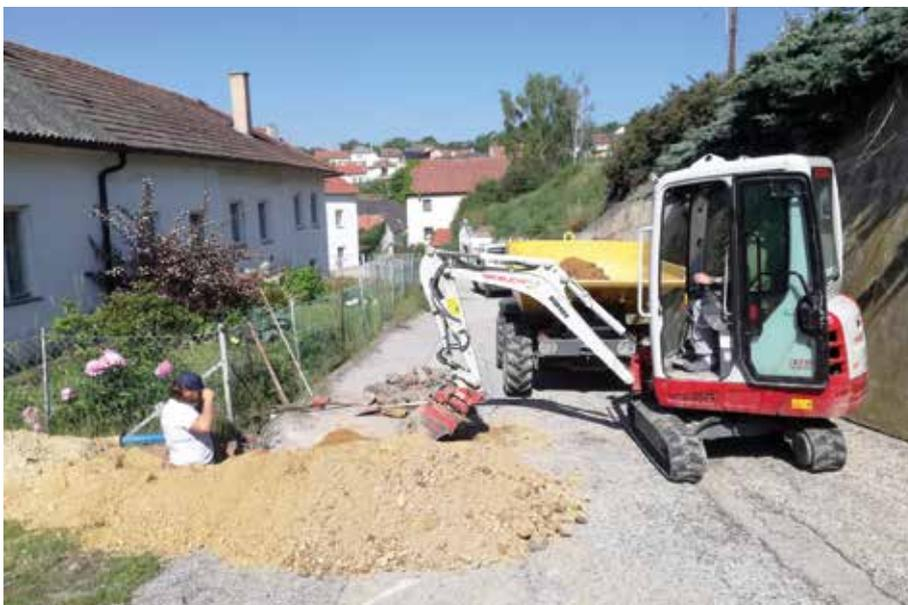
**Sanierung vom „Am Mittersteig“** in Gösing: Die Firma Baumeister Karl Sedlmayer GesmbH aus Grafenwörth hat vor kurzem mit den Bauarbeiten für die Straßensanierung vom „Am Mittersteig“ in Gösing vom Pfarrhof bis zur Kreuzung mit der Unteren Zeile begonnen. Auf dem Foto ist erkennbar, wie im ersten Schritt die Wasserhausanschlussleitungen freigegeben werden. In diesem Zuge werden auch die Leitungseinbauten saniert werden. Die Bauarbeiten werden rund zwei Monate dauern.
