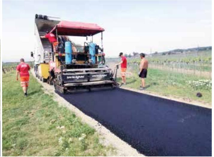
**Neuasphaltierung vom Steinagrund und Diebstein:** Der südliche Querweg vom Steinagrund und beim Diebstein wird von der Fa. Hengl neu asphaltiert. In diesem Zuge werden auch einige Asphaltlöcher im Dorner saniert.
